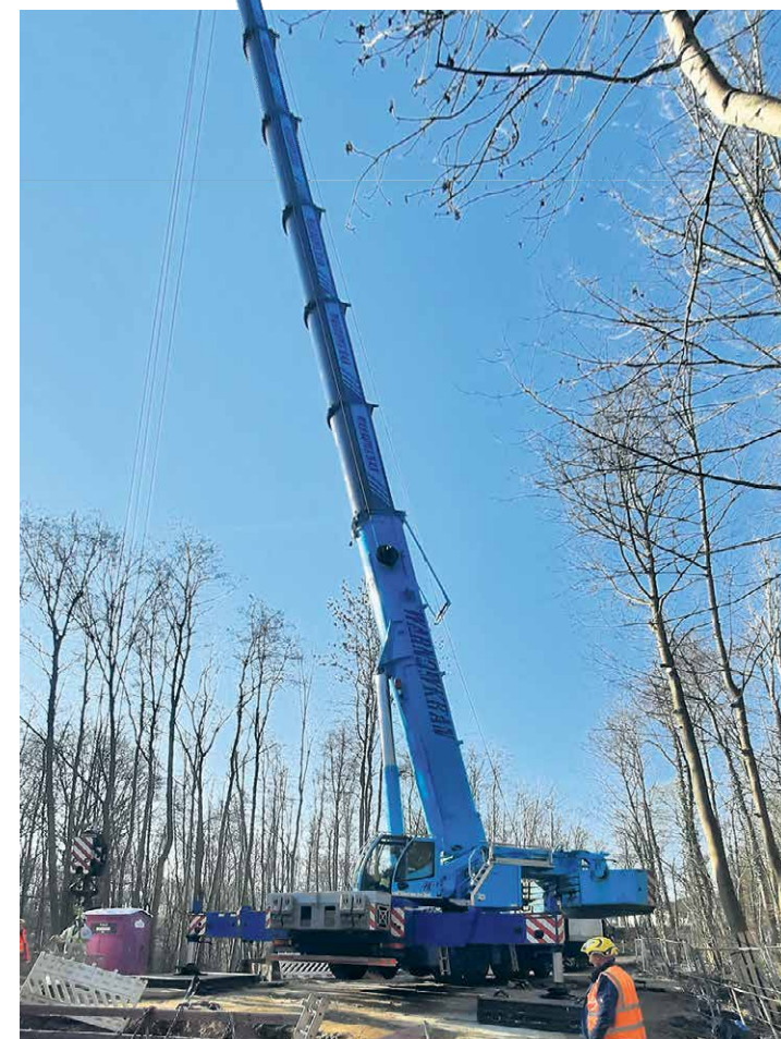
Schweres Gerät im Gehölz für eine Infrastruktur, die niemand sieht: Ein Mobilkran hebt die Betonschacht-Elemente für das neue Abwasserpumpwerk in Proseken ein.
