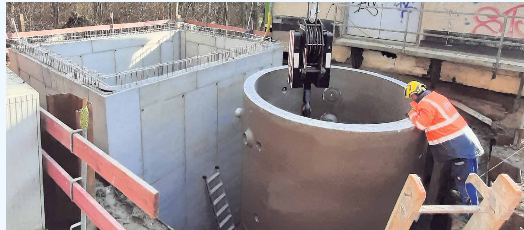
Der imposante Bau des Abwasserpumpwerks in Proseken.
