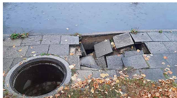
▲ Diese Regenanschlussleitung wurde unterspült.
