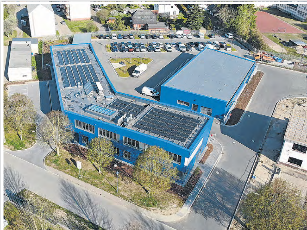
Das Verbandsgebäude in Lübow aus der Luft. Hier wird bereits mittels Photovoltaik der gesamte Eigenbedarf gedeckt.
