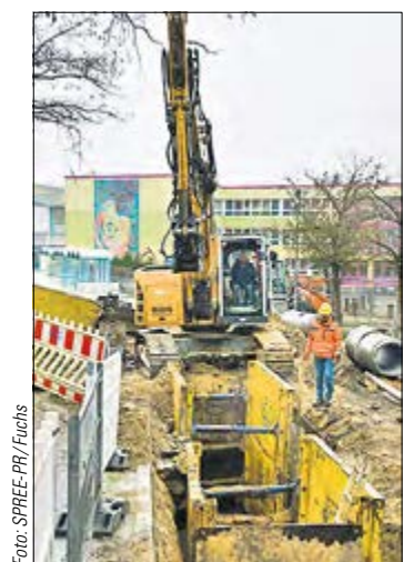
Zum Teil finden die Bauarbeiten in sechs Metern Tiefe statt. Foto: SPREE-PR / Fuchs
