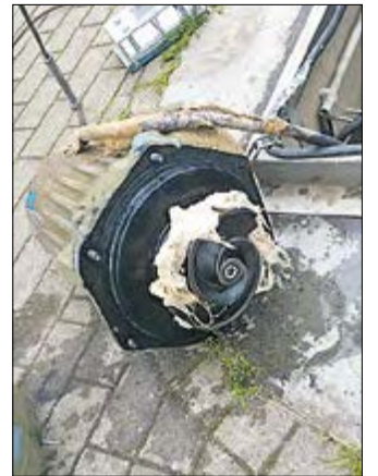
Deutlich im Bild zu sehen ist die Zopfbildung. So heißt in der Fachsprache das Festsetzen miteinander verspinnender fadenförmiger Stoffe an Hindernissen und Einbauten im Kanal, wie hier bei einer Pumpe.
