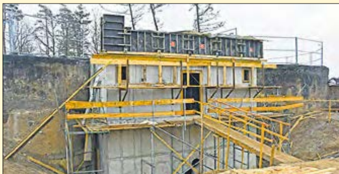
Die beiden Trinkwasserbehälter bei Zurow liegen frei. Künftig führt ein ebenerdiger Zugang ins Innere der Kolosse.
