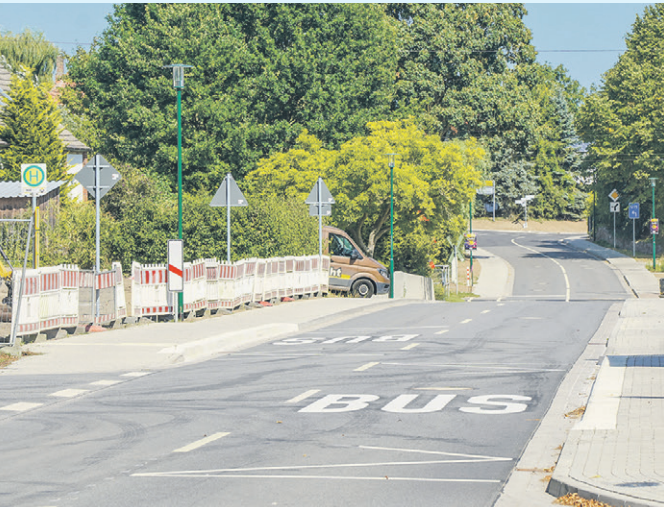
Blick in die neu ausgebaute Bahnhofstraße in Dorf Mecklenburg: Fahrzeuge fahren nun über eine breitere Fahrbahn. Fußgänger und Passanten müssen auf dem neuen Gehweg weniger auf Stolperfallen achten und können die barrierefreien Bushaltestellen nutzen.
