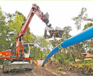
Die neuen Leitungen versorgen das Industrie- und Gewerbegebiet Hornstorf. Foto: SPREE-PR/Petsch
