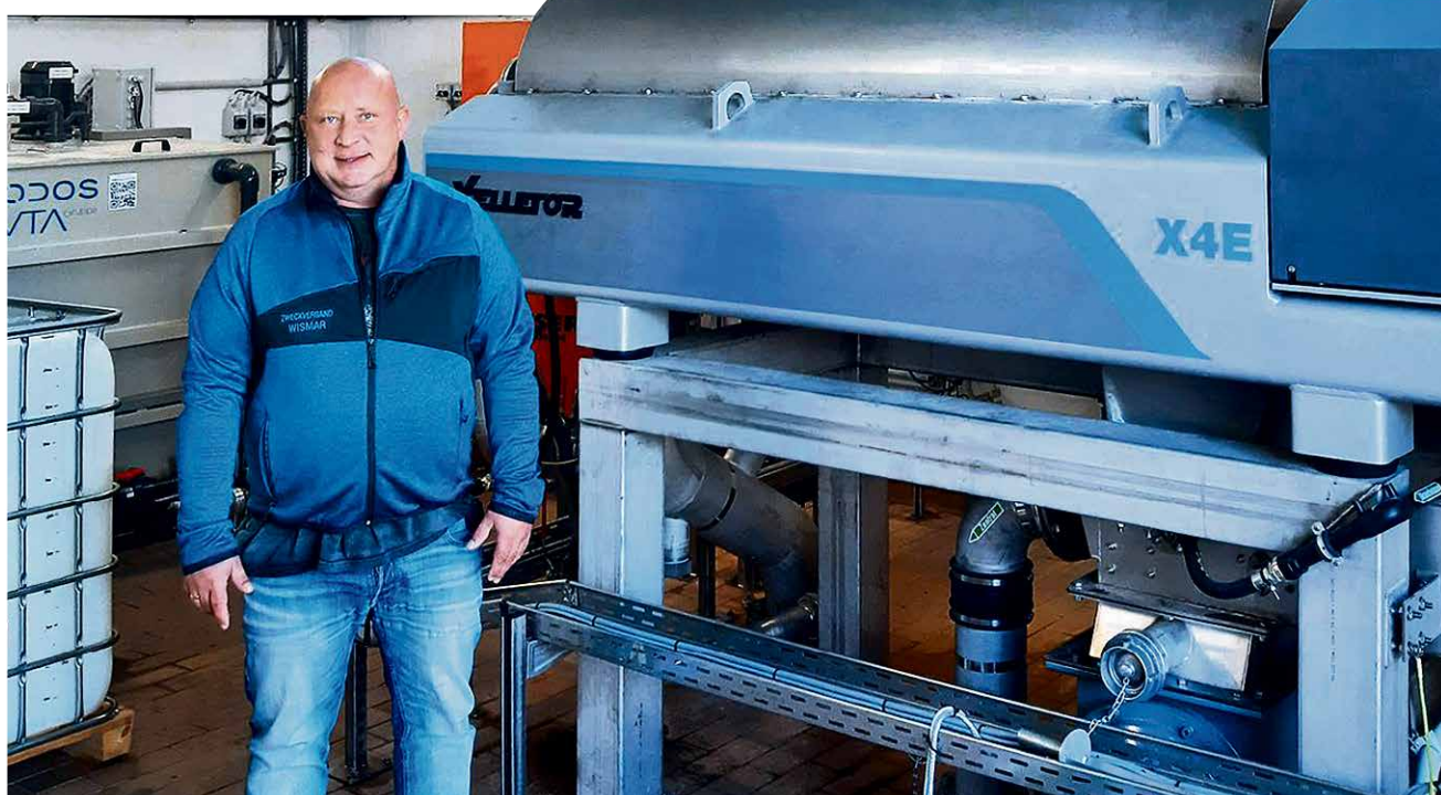
Der Betrieb der Kläranlage wurde ständig überwacht, damit die Modernisierung vorgenommen werden konnte.
