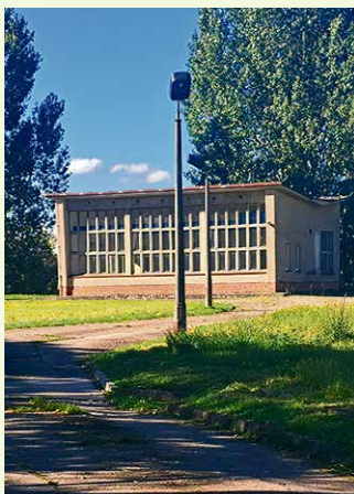
Das Hauptpumpwerk Neukloster stammt aus den 1970er-Jahren und soll saniert werden.
