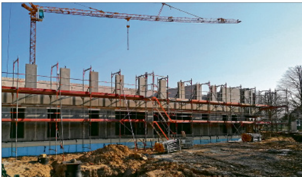
Die Rohbauarbeiten waren Anfang April bereits im zweiten Obergeschoss angekommen. Im März 2021 soll der Verwaltungssitz in Lübow fertig sein.
