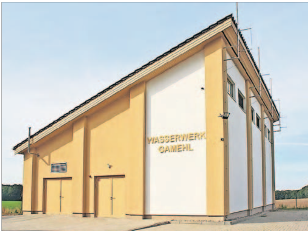
Ein Schmuckstück für unser Trinkwasser: Im neuen Wasserwerk Gamehl wird täglich aus bis zu 5.000 m 3 Rohwasser das Lebensmittel Nr. 1 gefördert.
